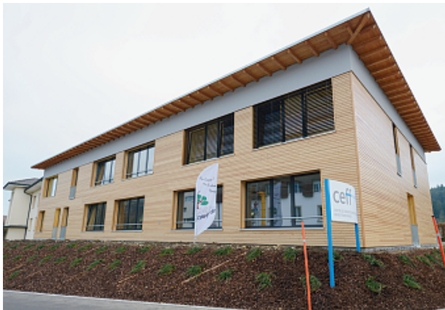
La nouvelle construction de bois, attenante à l'ancien bâtiment, répond aux normes Minergie. STÉPHANE GERBER
